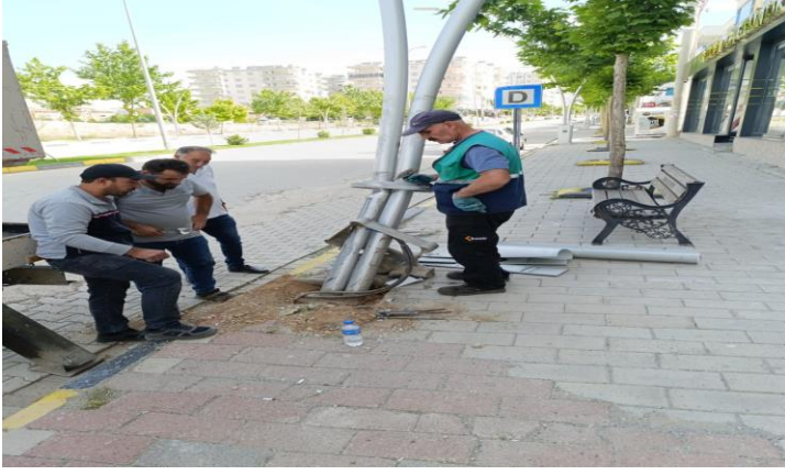
*refüjlerde bulunan elektrik direklerinin onarımı
