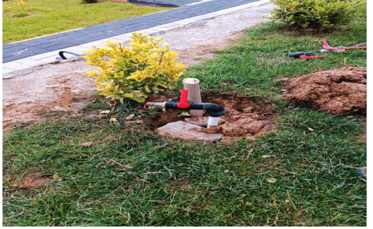
*parklarda bulunan musluk ve su malzemelerinin onarımı
